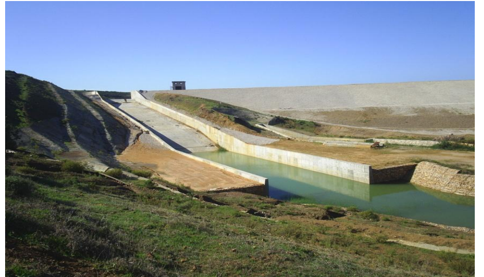
منظر عام لمفرغ مياه سد الحركة
